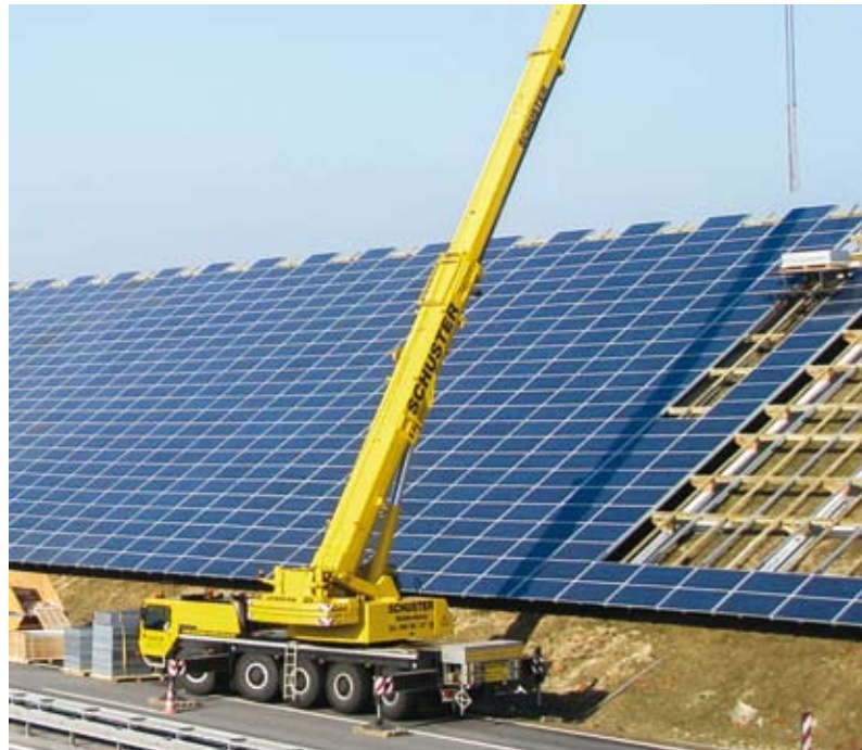
Lärmschutzwall Töging a. Inn, Quelle: Nicola Gradl/Wikipedia
