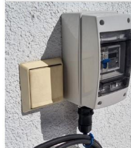
Anschlussbeispiel mit Wieland Stecker und Smart Meter
